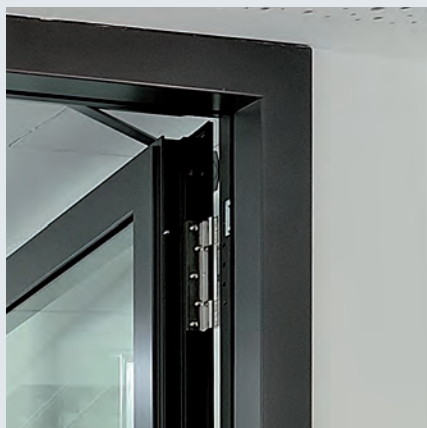
Zarge vorgerüstet für Obentürschließer
