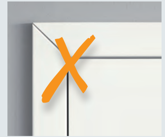
Holzzarge mit sichtbaren Gehrungen
