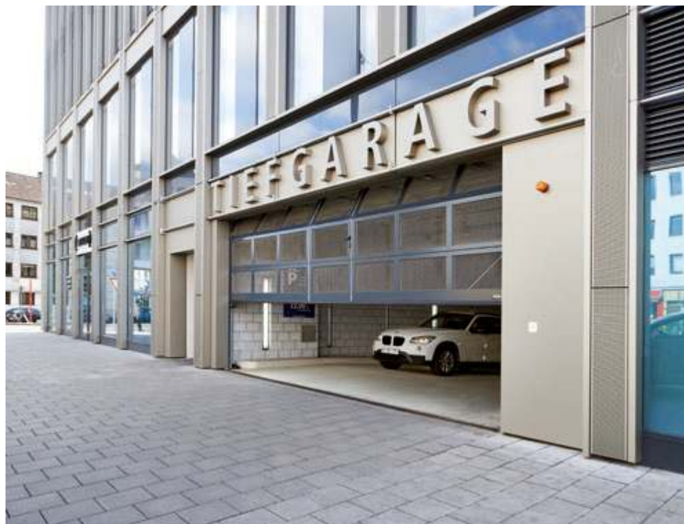
OBE N RECHTS. ALR F42 mit bauseitiger, flächenbündiger Beplankung aus Schichtpressplatten
