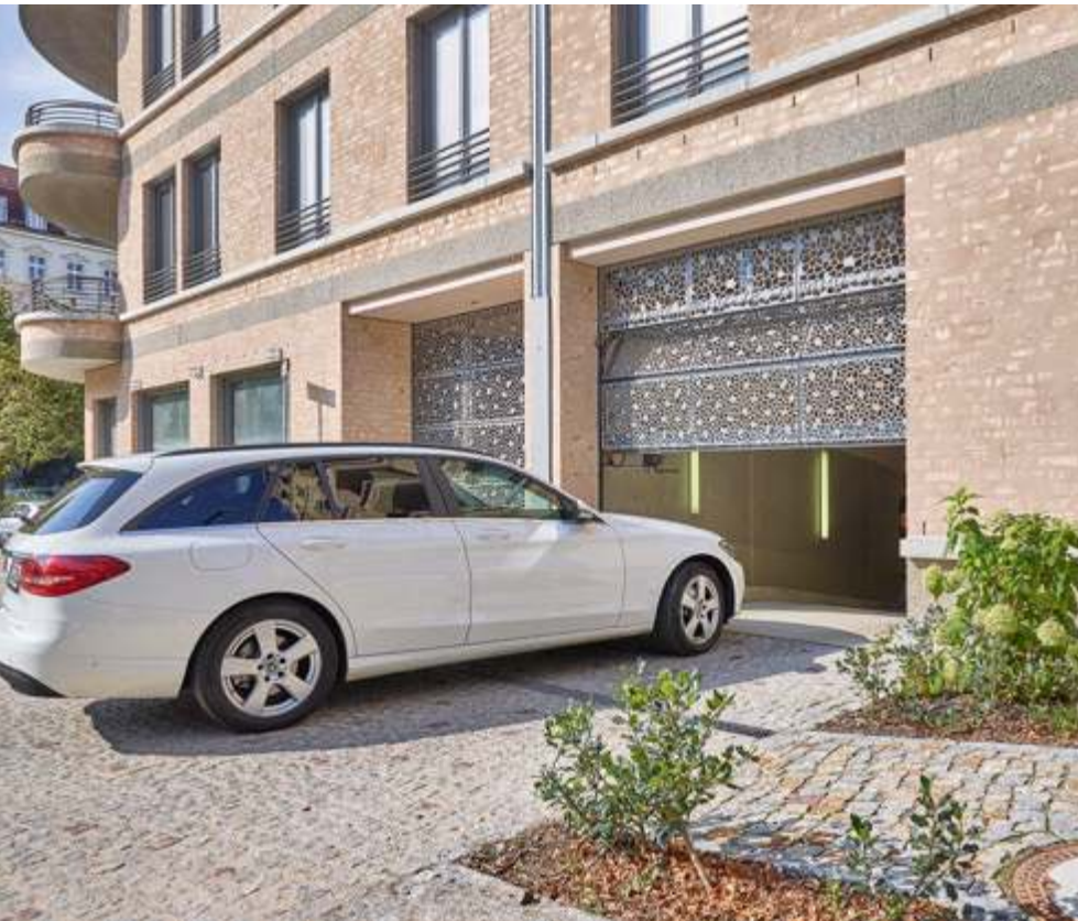
OBE N LINKS. ALR F42 mit bauseitiger Gitter-Füllung
